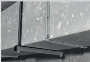
Легкая монтажная шина FLS, прокладка EMS 31
