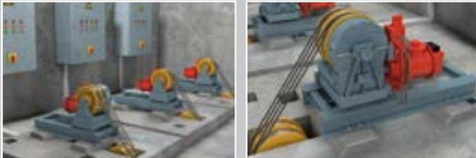
Приводной механизм лифта должен быть закреплен высокоэффективными анкерными системами. Высокотехнологичные и надежные химические анкеры, так же как и высокоэффективные стальные втулочные анкеры — самый правильный выбор.
