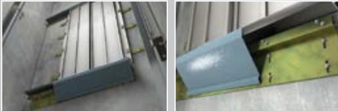
В зависимости от технических условий — механические распорные анкера обеспечивают высокие нагрузки, даже если они установлены близко к краю строительного основания — что обычно является важным условием при креплении дверей шахты. Анкера fischer имеют различные варианты исполнения головок и обеспечивают быстрый и простой монтаж.
