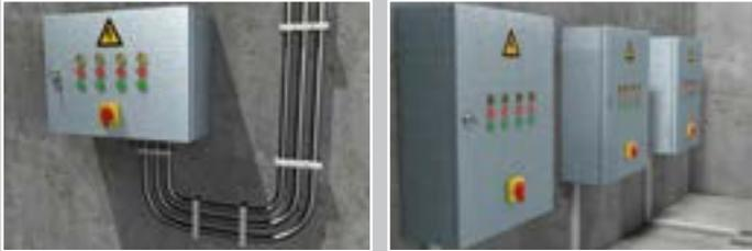
При монтаже электрооборудования, например, распределительных шкафов, нейлоновые дюбели гарантируют быстрый и надежный монтаж в большинстве строительных материалов. Для более высоких нагрузок наиболее подходящими будут стальные распорные анкеры или химический крепеж.
